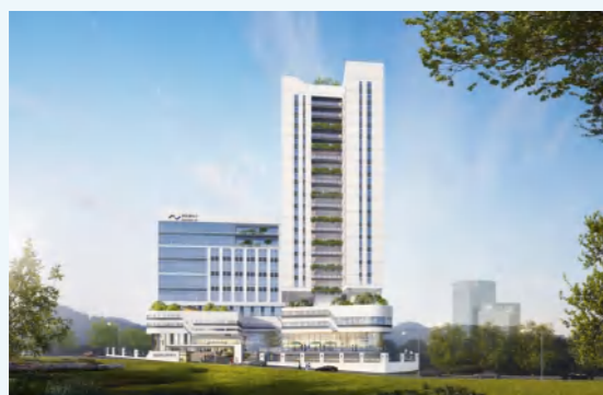
深圳产业基地（建设中）
