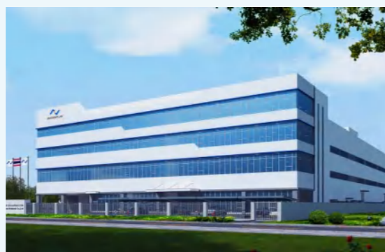
泰国生产基地（建设中）
